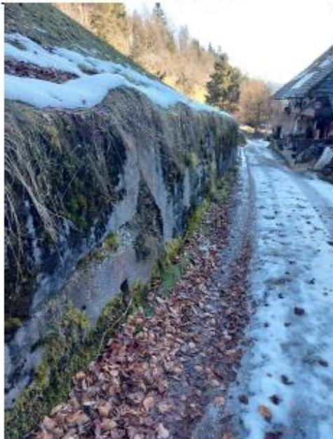
Foto 2: Stützmauer mit Ausbauchung, Abplatzungen und verschiedenen Rissgenerationen
